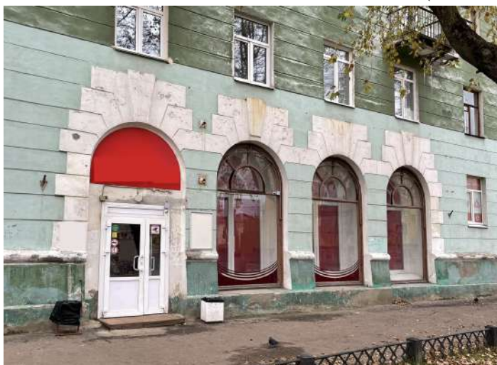
Рисунок 5.1.78 – Пример окон «в пол» на фасаде дома № 8 по пр-кту Ленина
