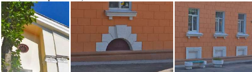
Рисунки 5.1.127–5.1.129 – Примеры оконных проемов в чердачных и подвальных помещениях на фасаде домов № 17 и 27 по пр-кту Ленина
