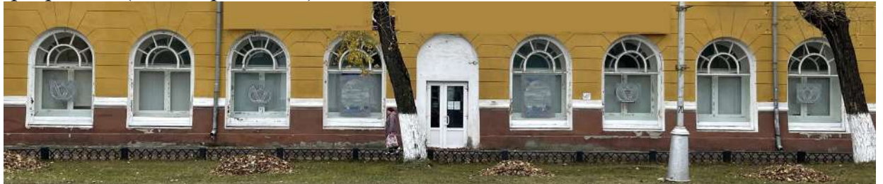
Рисунок 5.1.130 – Пример оконных и дверных проемов в нежилом помещении первого этажа дома № 10 по пр-кту Ленина
