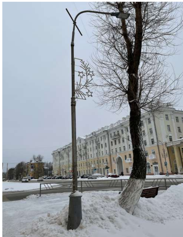
Рисунок 5.2.3.3 – Пример опоры освещения по пр-кту Ленина
