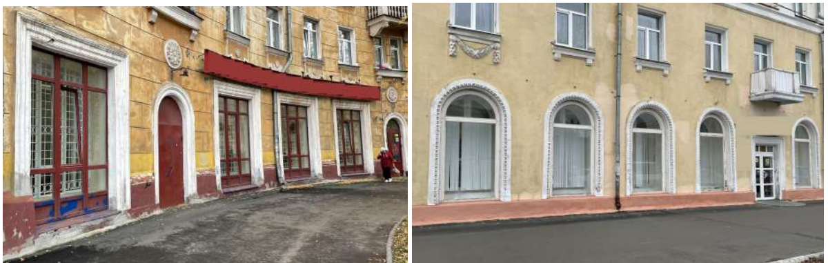
Рисунки 5.1.131 и 5.1.132 – Примеры оконных и дверных проемов в нежилых помещениях первого этажа домов № 1 и 13 по пр-кту Ленина
