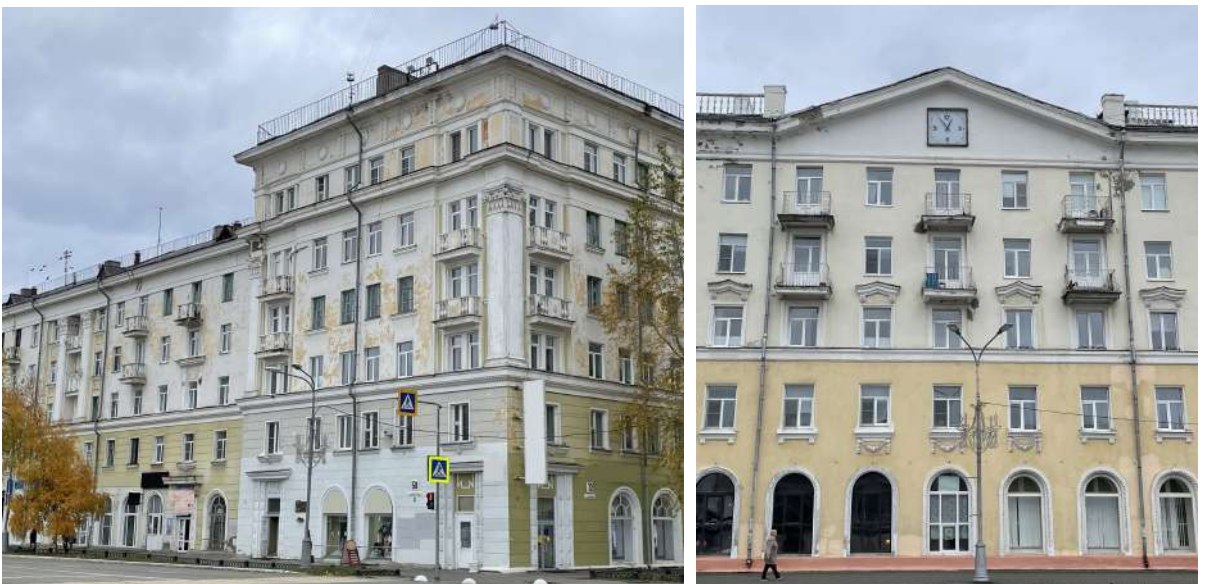
Рисунки 5.1.107 и 5.1.108 – Примеры размещения балконов в уровне четвертого и пятого этажей на фасадах домов № 12 и 13 по пр-кту Ленина
