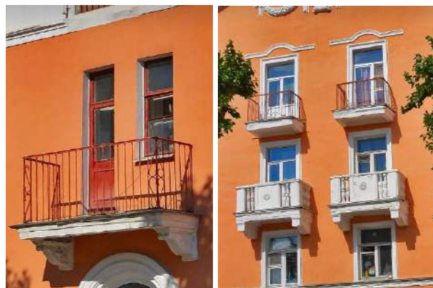
Рисунки 5.1.74 и 5.1.75 – Примеры балконов на фасадах домов № 21 и 33 по пр-кту Ленина
