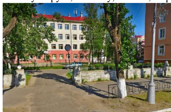
Рисунок 5.2.2.2 – Пример высокого декоративного ограждения из сплошной кладки в сочетании с пилонами между домами № 31 и 33 по пр-кту Ленина
