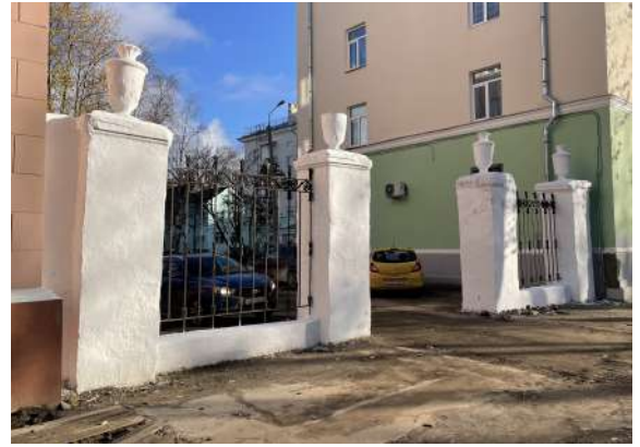
Рисунок 5.2.2.4 – Примеры высокого декоративного ограждения из визуально проницаемого ограждения в сочетании с пилонами между домами № 35 и 37 по пр-кту Ленина
