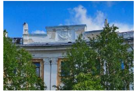
Рисунок 5.1.30 – Пример аттика на фасаде дома № 1 по пр-кту Ленина
