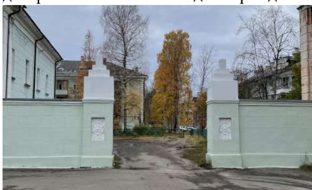
Рисунок 5.2.2.1 – Пример высокого декоративного ограждения из сплошной кладки в сочетании с пилонами между домом № 24 по пр-кту Ленина и зданием, расположенным по адресу: пр-кт Ленина, д. 26
