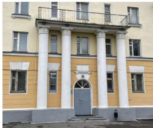
Рисунок 5.1.36 – Пример колонн на фасаде дома № 40 по пр-кту Ленина
