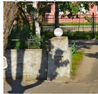
Рисунок 5.1.92 – Пример шара на ограждении между домами № 29 и 33 по пр-кту Ленина
