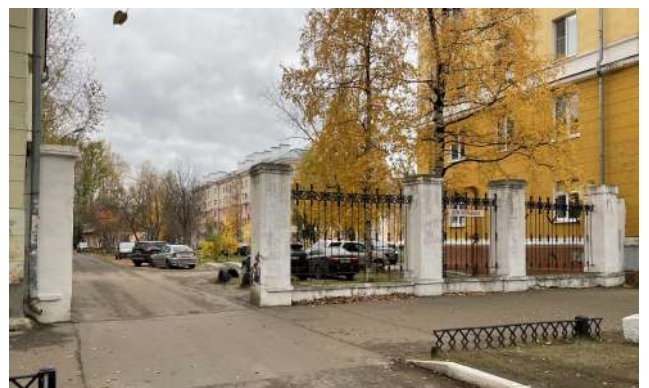
Рисунок 5.1.87 – Пример пилонов в ограждении между домами № 10 и 12 по пр-кту Ленина
