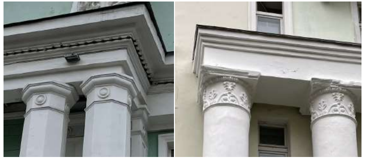
Рисунки 5.1.40 и 5.1.41 – Примеры капителей на колоннах фасадов домов № 26 и 38 по пр-кту Ленина
