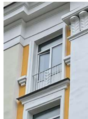
Рисунок 5.1.77 – Пример французского балкона на фасаде дома № 16 по пр-кту Ленина
