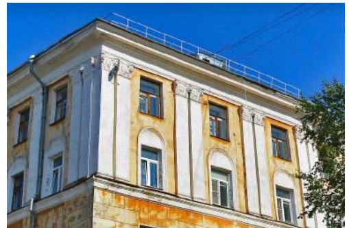
Рисунок 5.1.47 – Пример пилястра на фасаде дома № 1 по пр-кту Ленина
