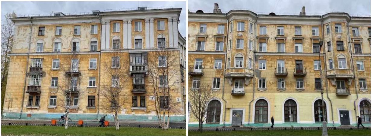
Рисунки 5.1.101 и 5.1.102 – Примеры размещения балконов в уровне второго и третьего этажей на фасадах домов № 2 и 4 по пр-кту Ленина
