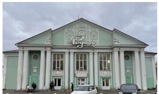
Рисунок 5.1.32 – Пример фронтона на фасаде здания, расположенного по адресу: пр-кт Ленина, д. 26
