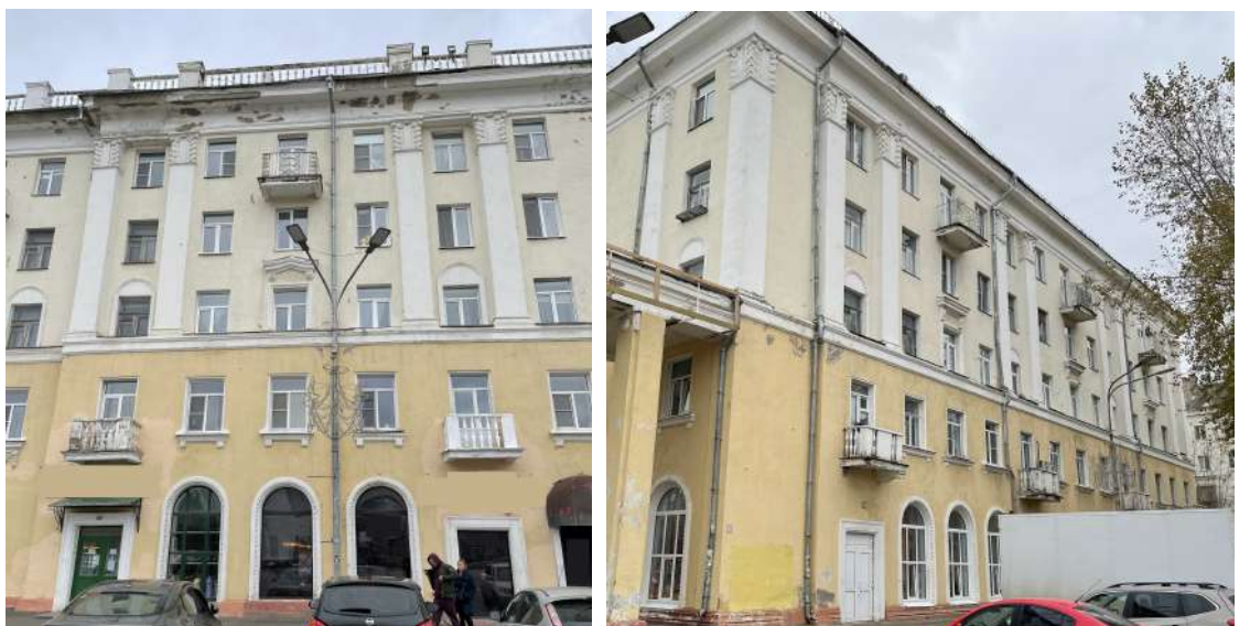
Рисунки 5.1.103 и 5.1.104 – Примеры размещения балконов в уровне второго и пятого этажей на фасадах домов № 13 и 15 по пр-кту Ленина
