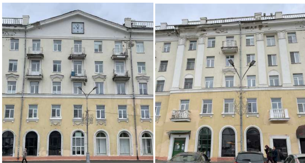
Рисунки 5.1.120 и 5.1.121 – Примеры расположения балконов на фасаде дома № 13 по пр-кту Ленина в смежных и не смежных уровнях по горизонтали
