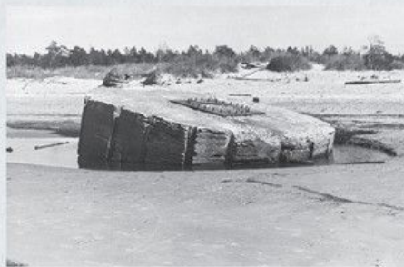
▲ Фундамент под орудия батареи на острове Ягры. 1941 год. В годы войны на таких основаниях располагались 152-мм орудия системы КАНЭ
