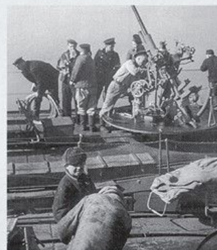
▲ Цех судостроительного завода № 402. В начале 40-х годов ▼ Монтаж зенитной установки на большом морском охотнике
